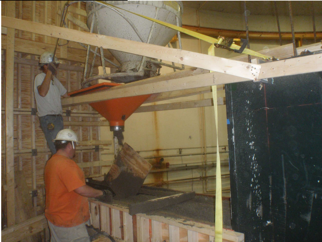
Concrete pour for the SHMS shield house.
